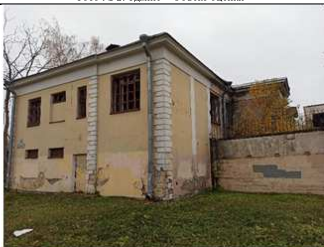
Фото № 4: Здание – Объект оценки
