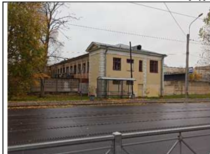
Фото № 1: Здание – Объект оценки
