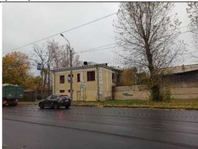
Фото № 2: Здание – Объект оценки
