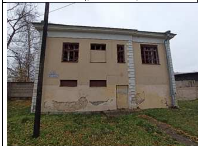
Фото № 3: Здание – Объект оценки
