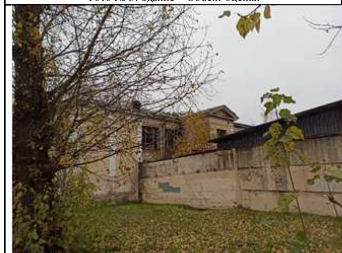
Фото № 5: Здание – Объект оценки
